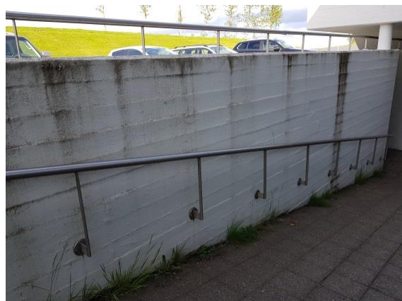
Háprýstipvo og mála þarf vegg.
