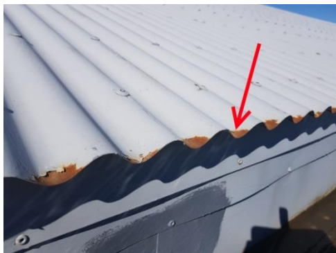
Á þessari mynd sést ryð í þakjárnri.
