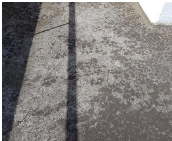
Stigapallur á austurhlið er orðinn töluvert veðraður og komnar frostskemmdir í hann.
