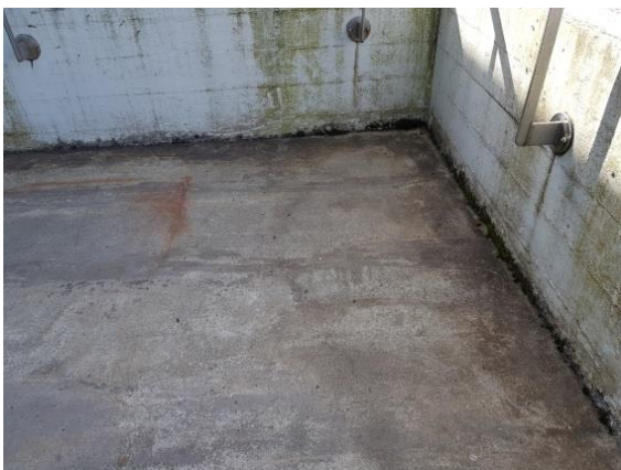
Mikið los er í filtun á stigapalli. Stigahandið þarf að háprýstipvo og mála.
