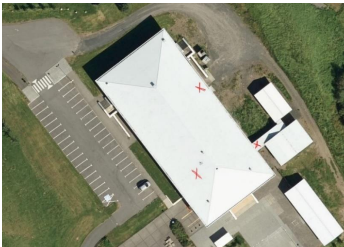
MYND 6 Eldri deild - staðsetningar byggingarsýna í skólahúsnæði tilgreindar með rauðum lit.
