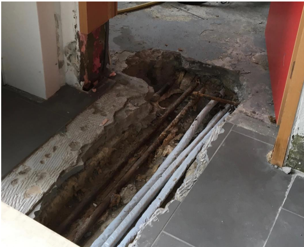
Mynd 3. Búið að opna áður nefnt gólf í við anddyri eldri deildar Varmárskóla.
