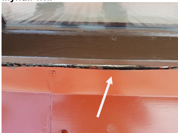
Frágangur flasningar við glugga í stölluðu þaki ekki góður. Breyta þarf þessum frágangi.
