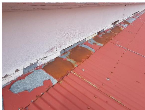
Frágangur við stallað þak. Hér er lagt til að veggur verði klæddur með sléttri álklæðningu.
