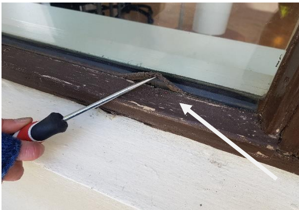
Toppfylling glerlista orðin laus og vatn á greiða leið niður í glerfals.
