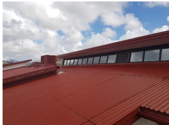
Lagt er til að skipt verði um glugga við stallað þak verði endurnýjaðir og setir verða nýjir gluggar sem bjóða upp á betri frágang við þak og veggfleti, t.d. ál-trégluggar. Þeir eru einnig viðhaldsléttir og henta t.d. þar sem erfitt er að ná til glugga.
