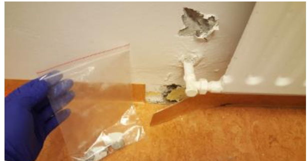
MYND 52: Sýnataka úr vegg
