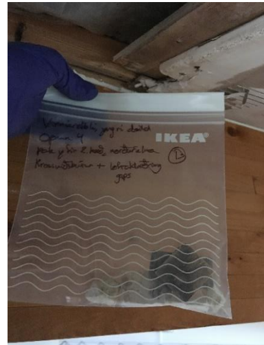
MYND 23: Sýni B4 –Yngri deild þak, 2.hæð, norðausturálma, krossviður og gipsklæðning.
